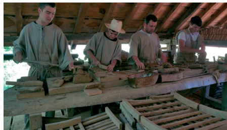
Chantier GUEDELON Renouvelé en 2018
